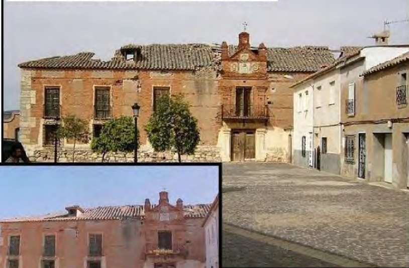
Estado del Palacio en el otoño del 2009
